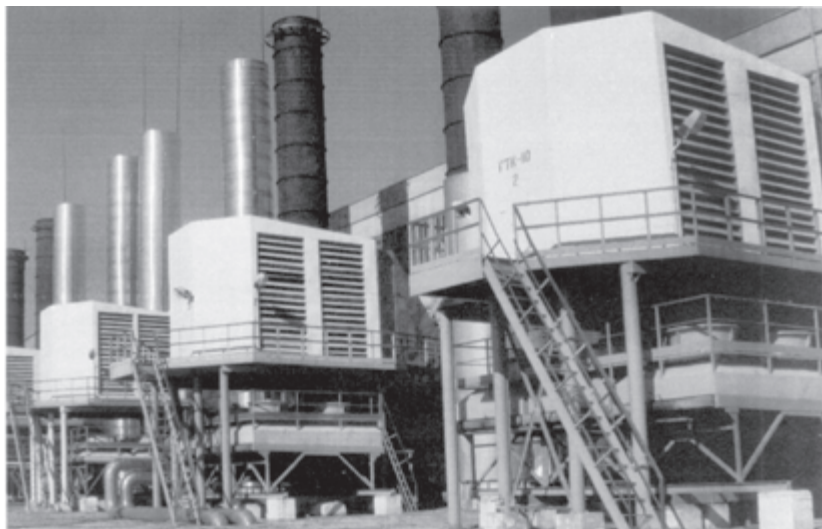
Компресорна станція магістрального газопроводу
