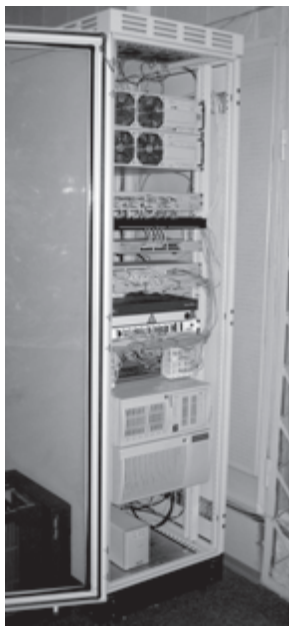
Центральний комутаційний вузол комп'ютерної мережі НТУУ "КП"
