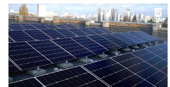
Потужність генерації – 14,8 кВт Загальна ємність зберігання енергії – 19,2 кВт·год
