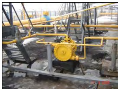
Турбодетандер-електрогенераторний агрегат
