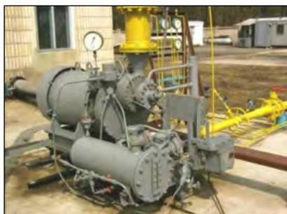
Турбодетандер-електрогенераторний агрегат
